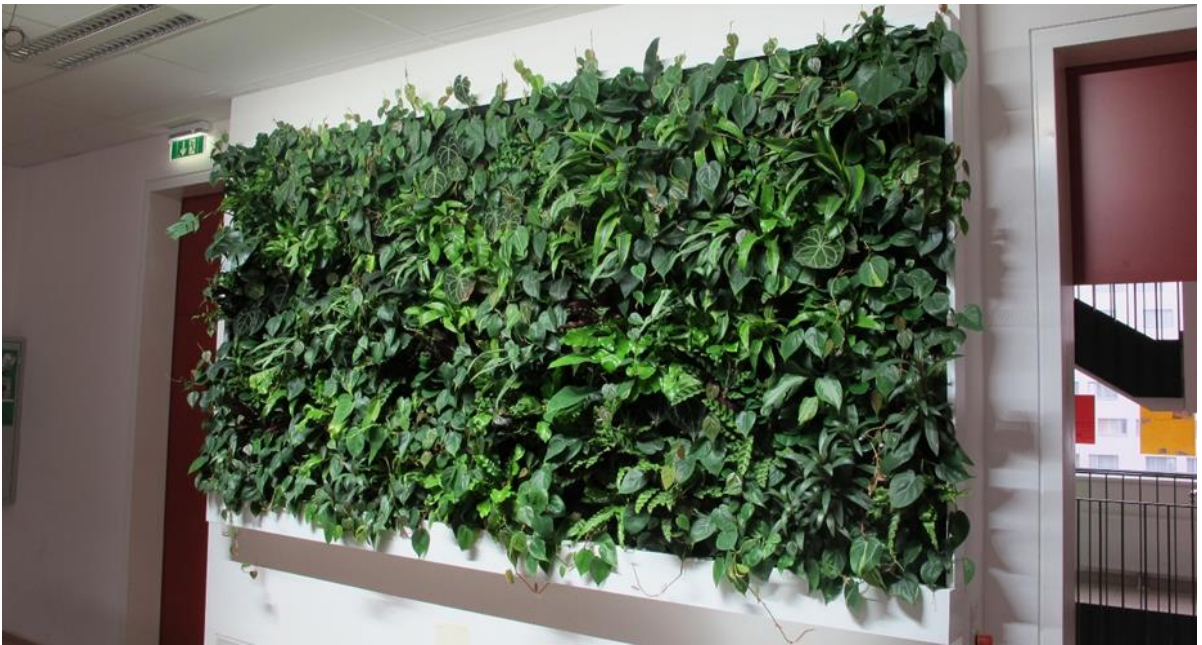
Abbildung 14: BRG 15 - Wandbegrünungssystem ohne Blumenerde bzw. Pflanzsubstrat (Fa. Florawall)
