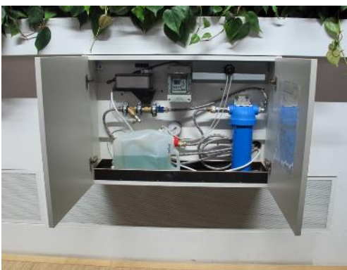
Abbildung 17: Technik-Box mit Steuerungs- und Regelungstechnik (Fa. Florawall) und Bewertung der Pflanzen und deren Vitalität nach einem Pflegedurchgang einer Wandbegrünung im Klassenraum
