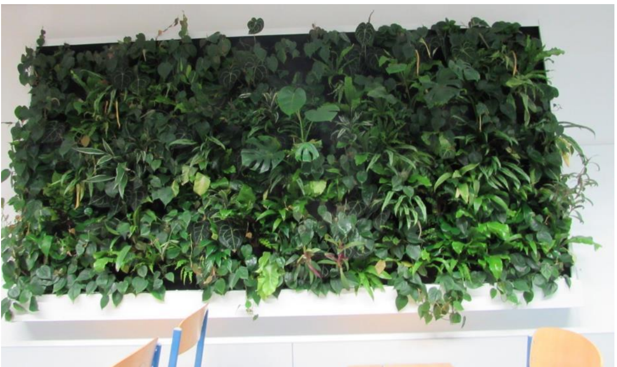
Abbildung 15: BRG 16 - Wandbegrünungssystem ohne Blumenerde bzw. Pflanzsubstrat (Fa. Florawall)
