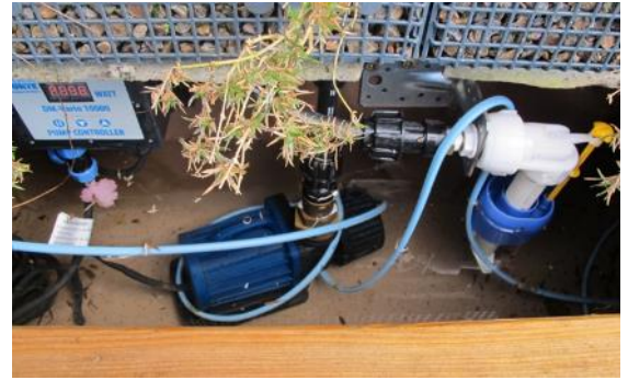
Abbildung 16: Bewässerungstechnik mit Wassertanklösung und Anwuchspflege (Fassadenbegrünung Fa. Optigrün): Zusätzliche händische Bewässerung nach dem Anpflanzen
