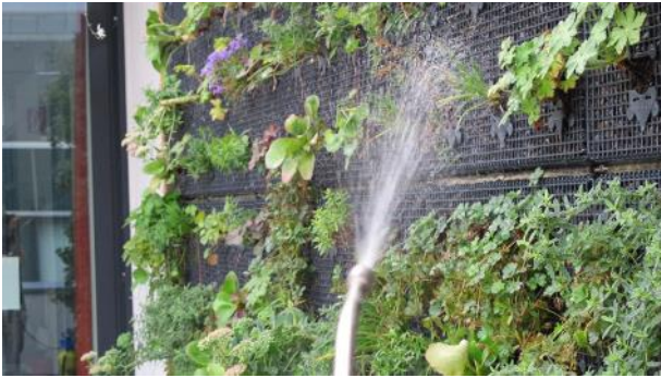
Abbildung 16: Bewässerungstechnik mit Wassertanklösung und Anwuchspflege (Fassadenbegrünung Fa. Optigrün): Zusätzliche händische Bewässerung nach dem Anpflanzen
