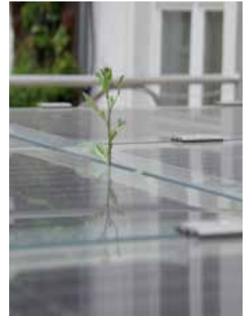
Abb. 45: PV-Module unbedingt vor Verschattung freihalten!
