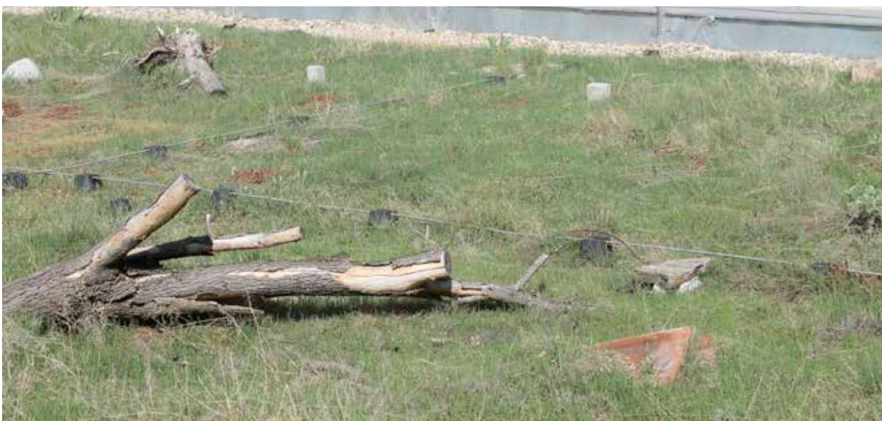
Abb. 41: Pannonisches Trockenrasendach mit Strukturbildnern.
