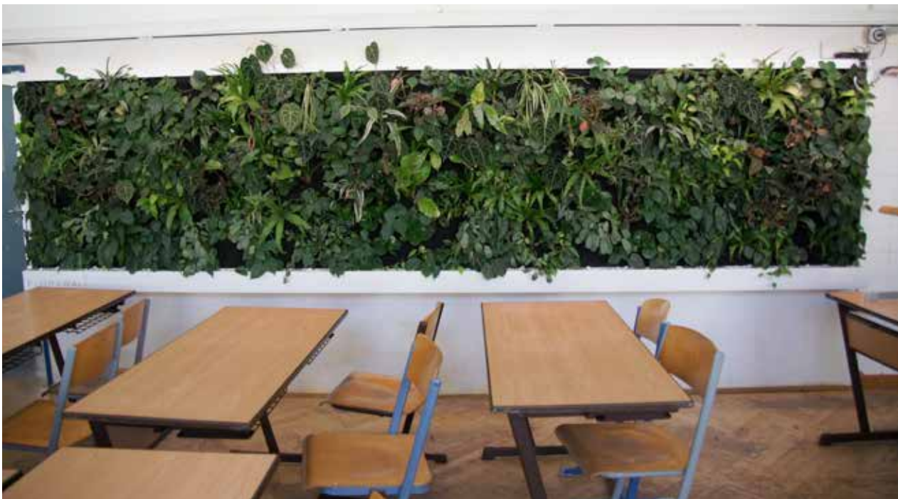
Abb. 14: Vliessystem im Klassenraum.
