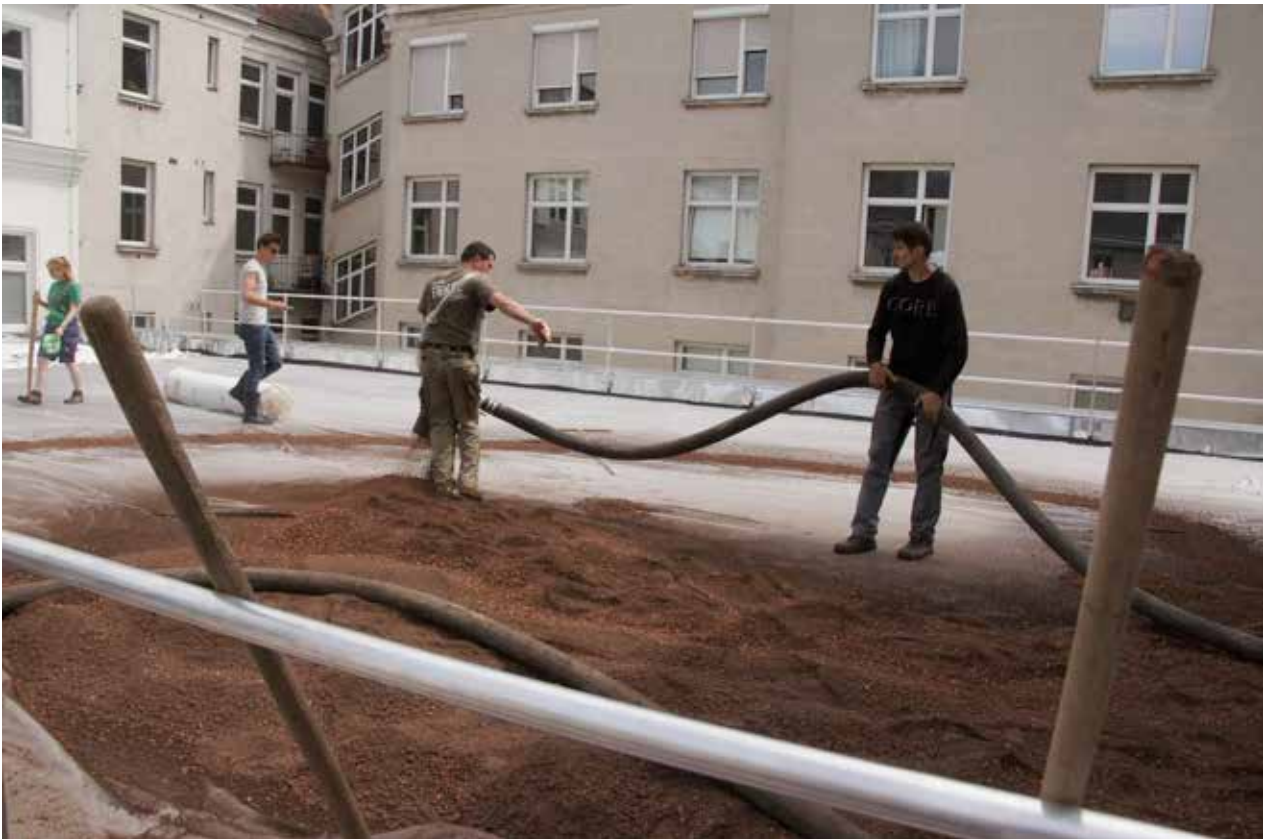
Abb. 4: Bau des Gründaches am Turnsaal des GRG 7 - Ausbringung des Substrates mit dem Silozug (Mai, 2016).
