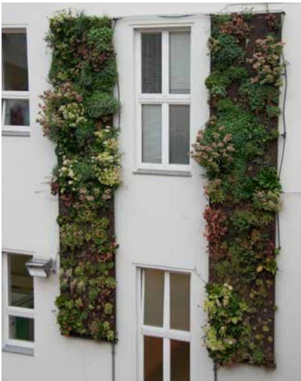
Abb. 36: wandgebundenes Kassettensystem im Innenhof.
