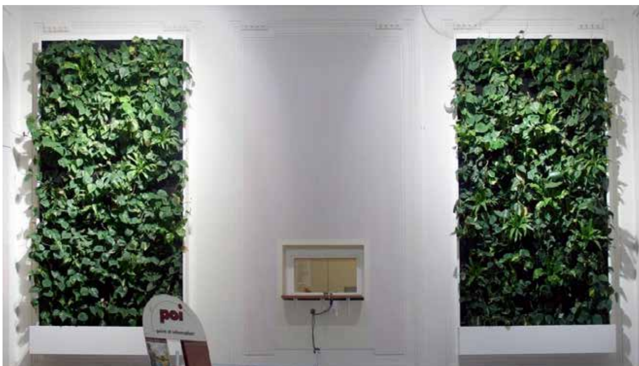
Abb. 16: Vliessystem mit Wassertank und Umlaufpumpe im Eingangsbereich.
