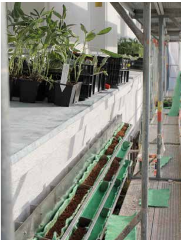
Abb. 5: Bepflanzung der Außenfassade mit Gerüst.
