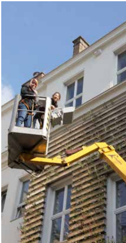
Abb. 29: Pflege der Grünfassade mit dem Hubsteiger.
