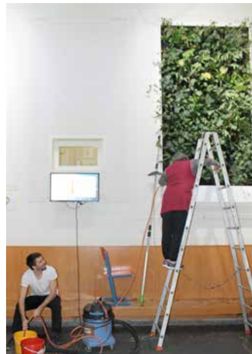
Abb. 18: Reinigung des Wassertanks.
