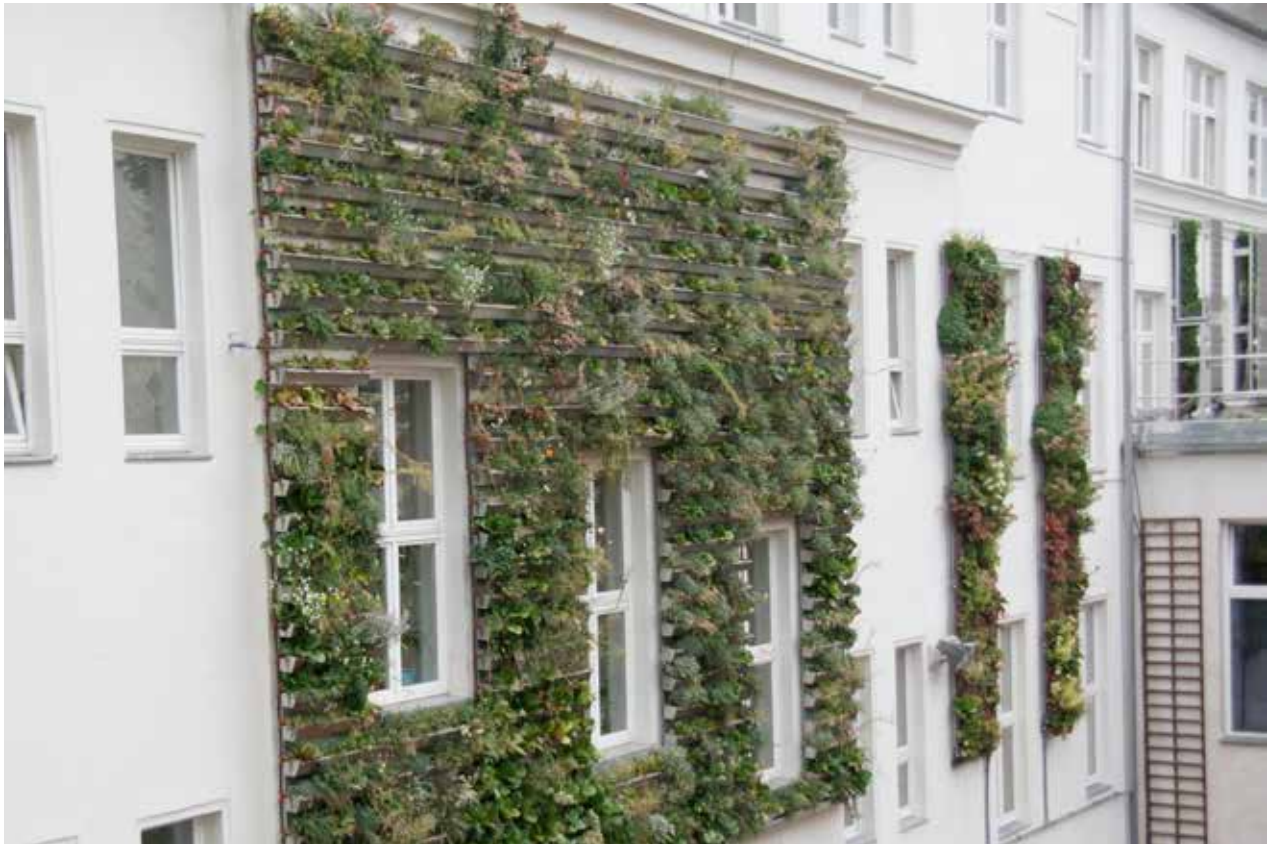
Abb. 21: unterschiedliche Fassadenbegrünungssysteme im Innenhof.
